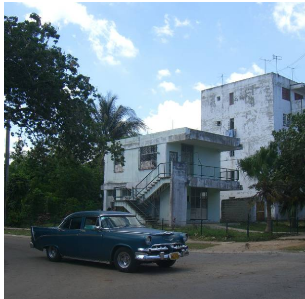
Abbildung 7: Gebäude eines Familienarztes in der Siedlung Alamar (Habana)
