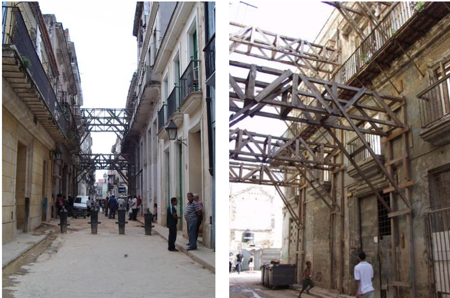
Abbildung 9: gestützte Gebäude in Habana Vieja
